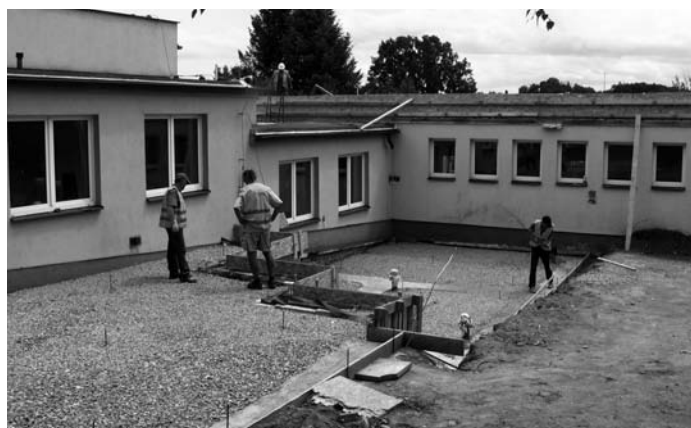
Zahájení prací v červenci 2017
