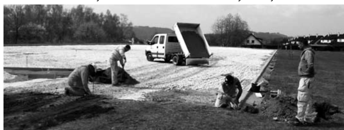
Výstavba lehkotletického areálu
