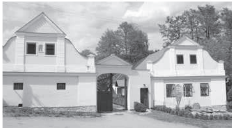
Zemědělská usedlost čp. 4 ve Skaličanech, foto Jan Kurz
