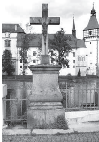
Křížek Na Slupi před opravou, foto Lukáš Vokroj
