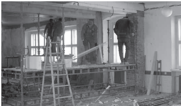
Rekonstrukce sálu, začátek stavby
