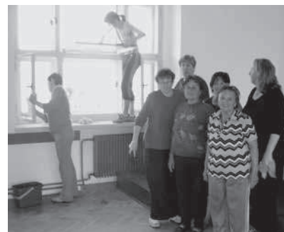
Rekonstrukce sálu, dokončovací práce
