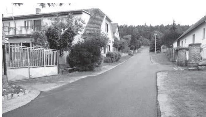
Opravená cesta od hasičárny, foto Václav Cheniček
