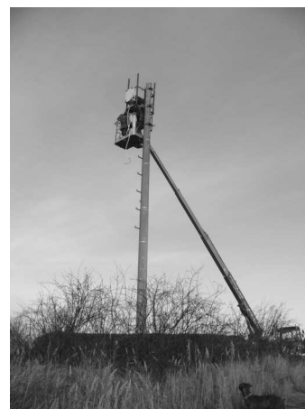
Osazování antén na stožár. Foto Pavel Šípek.
