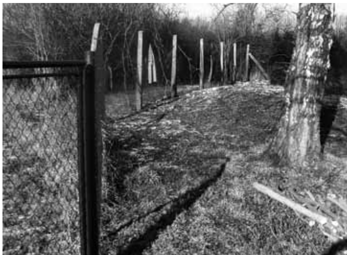
Oprava oplocení zahrady školy Velká Turná
