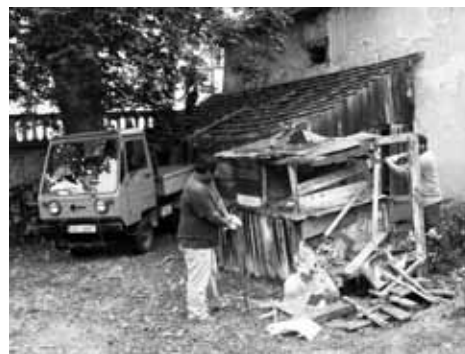
Demontáž přístaveb komenty
