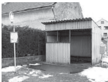
Čekárna před realizací
