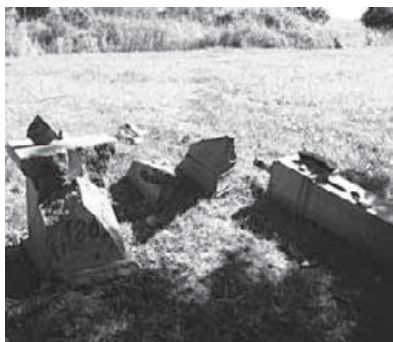
Rozpadlý kamenný podstavec křížku u obecního skladu
