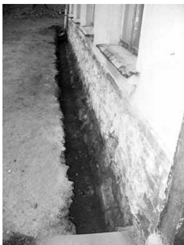
Oprava budovy školy Velká Turná čp.55 (provedeno za finančního příspěví Jihočeského kraje) - Foto Pavel Šípek
