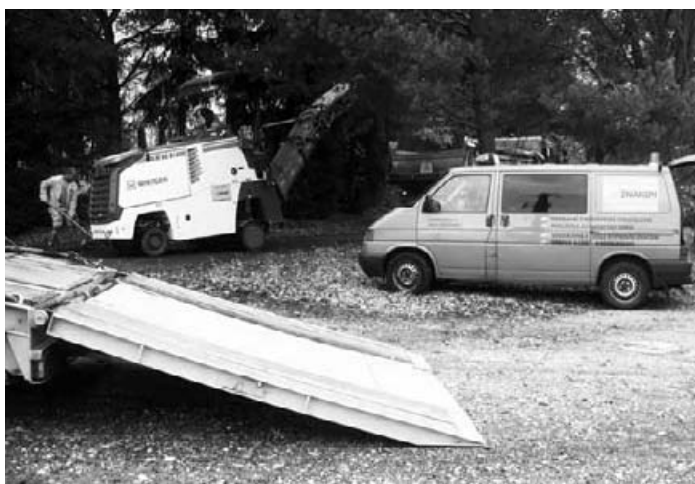
Oprava místní komunikace – dotace Jčk. - frézování vozovky
