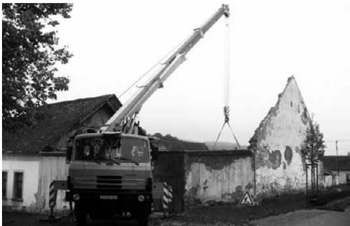
Oprava budovy čp.6 - skladový objekt
