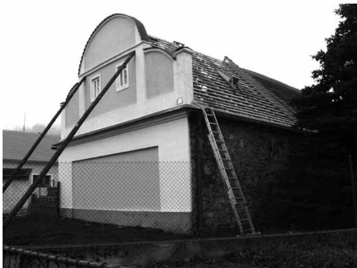
V průběhu oprav sýpky čp. 3 Pacelice
