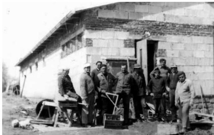
Výstavba kabin na hřišti v roce 1974
