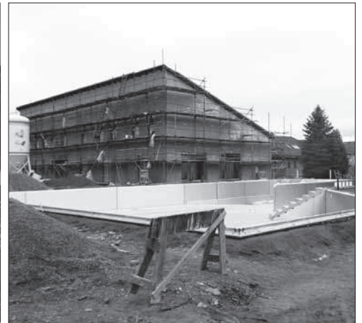
Zapuštěný bazén, foto ze dne 11.4.2013
