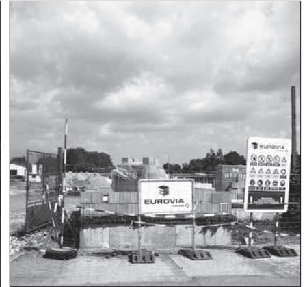
Základy budoucího vstupu a vrátnice, foto ze dne 22.5.2012
