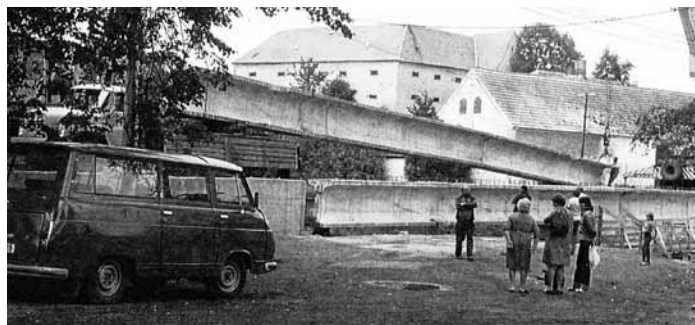
Ze stavby mostu v roce 1983
