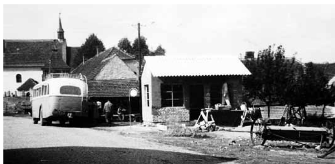
Výstavba autobusové čekárny na okraji prostranství po zbořeně kapličky sv. Jana Nepomuckého (fotoarchiv obce Lnáře)
