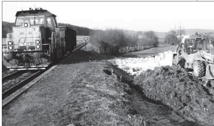
Čekárna ČD – bourání
