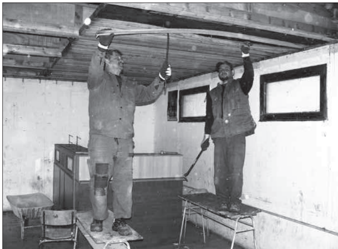
Demontáž stropu hlavního objektu v Letním areálu
