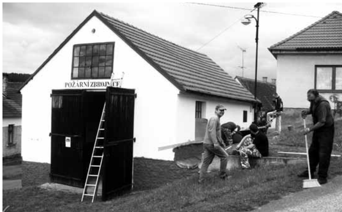
Oprava budovy požární zbrojnice
