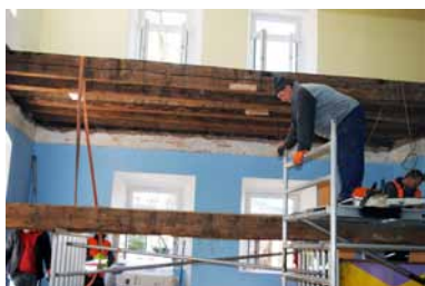
Demolice stropních trámů
