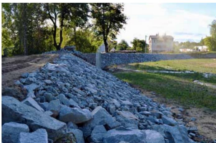
Oprava hráze Velký Humič
