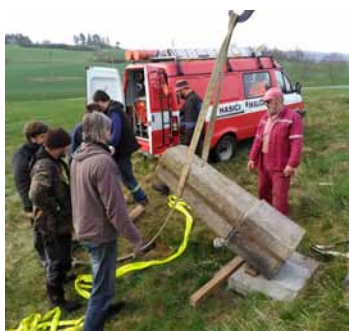
Znovuosazování kamenných částí
