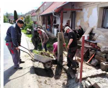
Terénní úpravy u obecního domu
