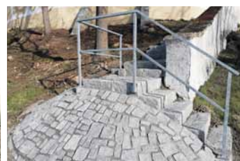
Pohled na nové schodiště se zabezpečením proti pádu a kamenným obložení skalního výběžku
