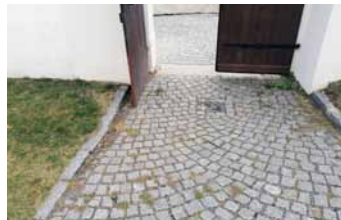
Plynulé navázání dláždění nového schodiště na chodník v areálu hřbitova
