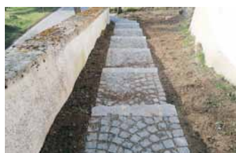
Pohled na nové schodiště směr Paštiky
