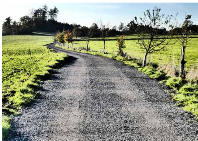
Opravená cesta ke křížku
