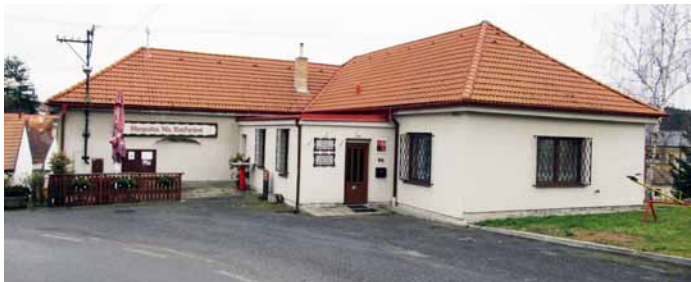
Budova OÚ Velká Turná čp. 41
