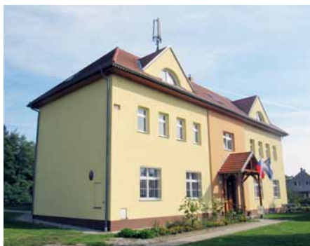
Opravená fasáda budovy OÚ Tchořovice čp. 77 v září 2022
