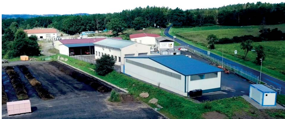
V areálu TSMB je administrativní budova (vpravo nahoře), garáže, prostory pro opravy techniky, sklad posypových materiálů, kompostárna, sběrný dvůr a re-use centrum
