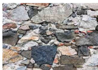
Typ starého zdiva na hospodářské budově panského dvora ve Tchořovicích
