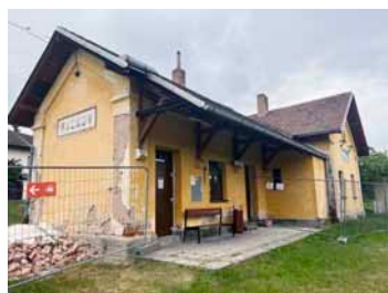
Nádražní budova před opravou
