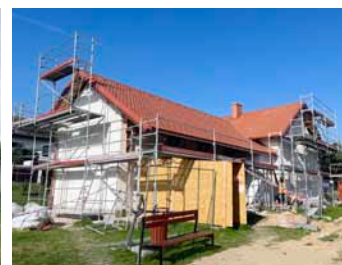
Probíhající oprava nádražního domku
