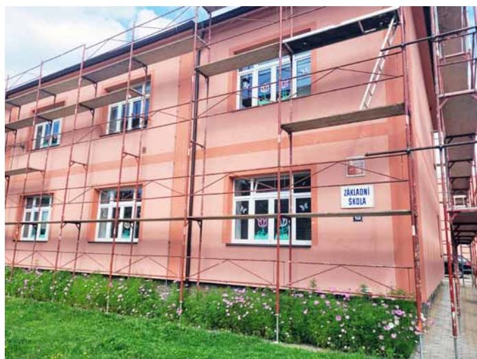
Opravy budovy Základní školy Lnáře
