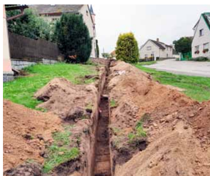
Výkopy v obci, foto Václav Cheniček
